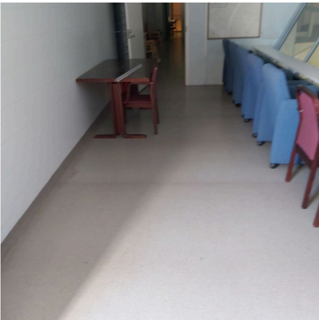
Ahti Laaksonen 13.06.2021 16:57 Suojaukset puuttuu !
