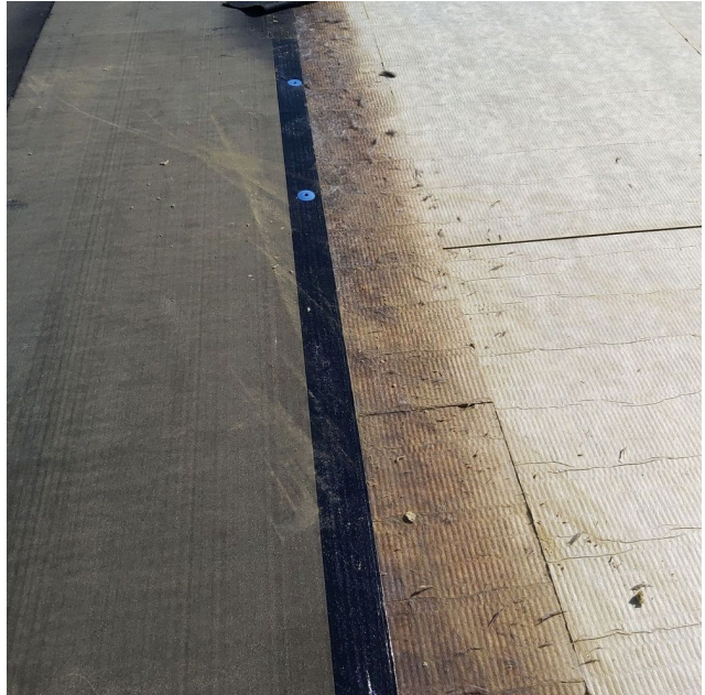
Ahti Laaksonen 13.06.2021 17:06 Pohjakermin Kiinnityksetet saumalta
