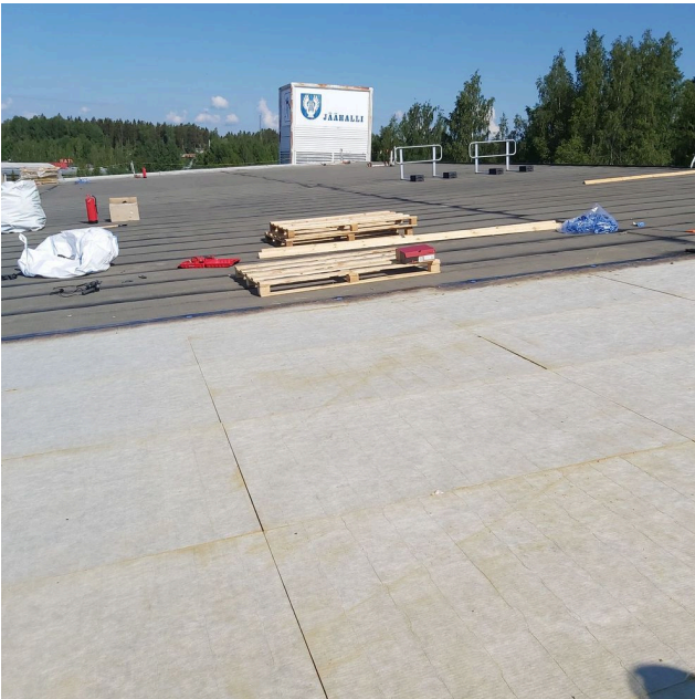
Ahti Laaksonen 13.06.2021 17:03 Uutta eristettä asennettuna
