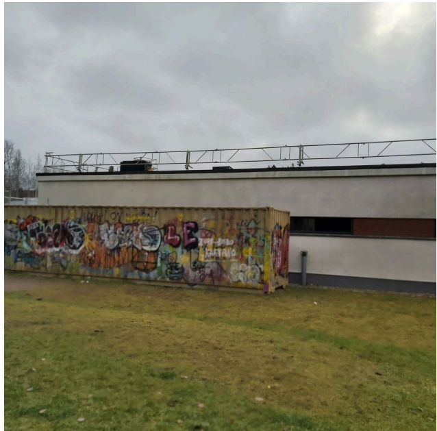
Ahti Laaksonen 21.11.2021 18:35 Työalue on putoamissuojattu vastapainokaiteilla !
